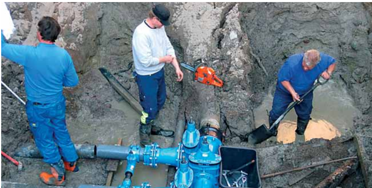
Byte av ventiler på huvudledning till Godby.
